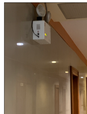
รูปที่ 3.2-13 การติดตั้งไฟฟ้าสำรองภายในโครงการ
